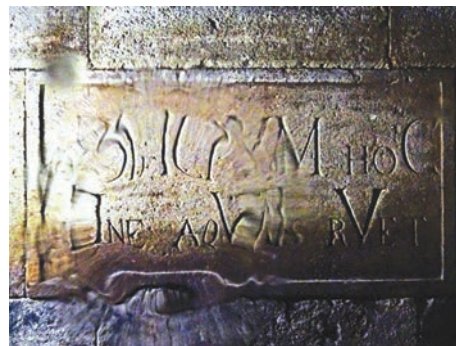
AEDIFICIVM HOC SINE AQVIS RVET (Tato stavba se bez vody zřítí)
